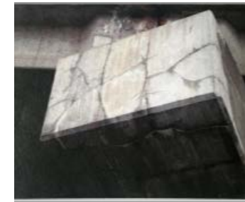
図2 断面修復材のひび割れ(改修後1年)
