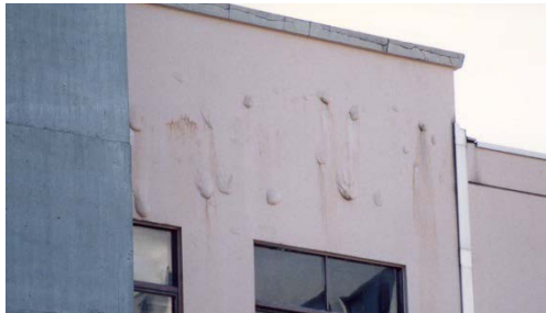
図1 防水形仕上塗材のふくれ
