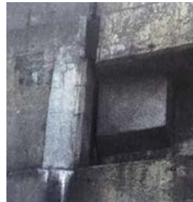
図2 断面修復材のひび割れ(改修後1年)
